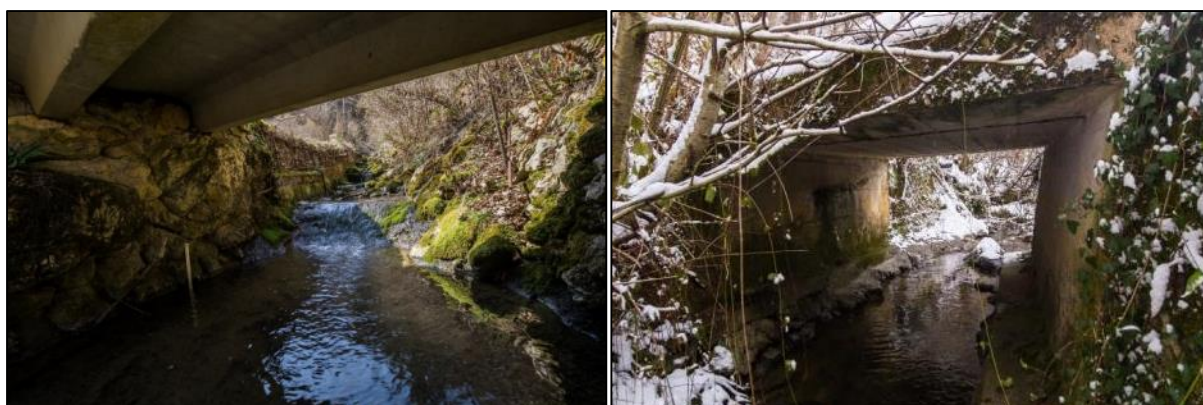
Slika 9: Meritve pritiska (vodostaja) na Rečici pod zgornjim (levo) in spodnjim mostom (desno).
